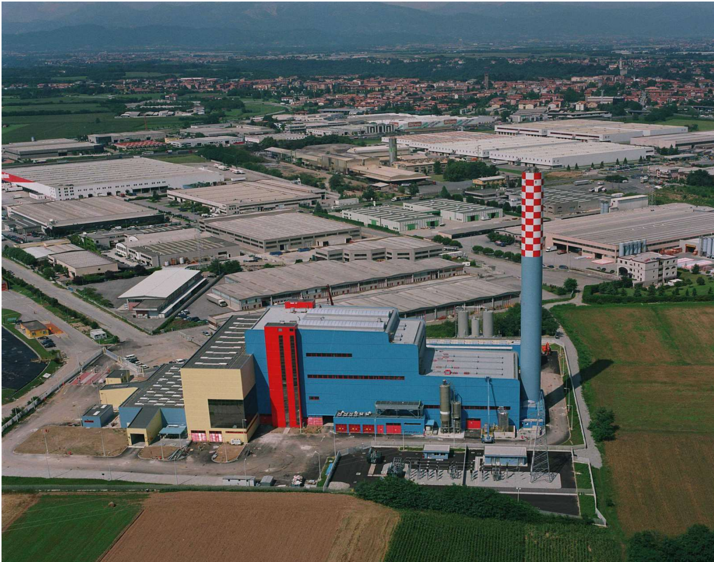
TERMOVALORIZZATORE DI TREZZO SULL'ADDA
