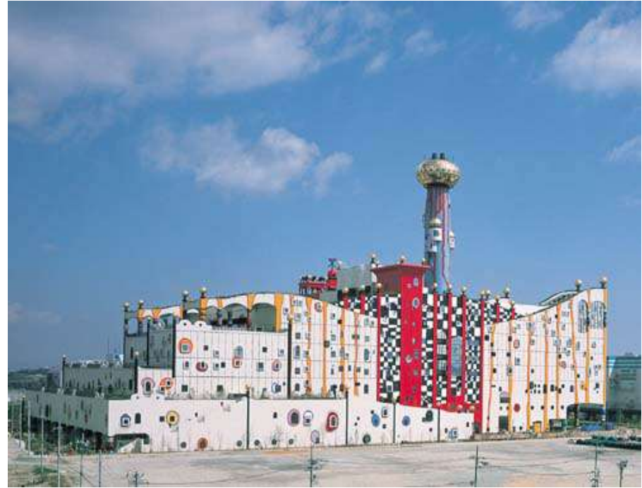
TERMOVALORIZZATORE DI OSAKA (2x18 t/ h)
