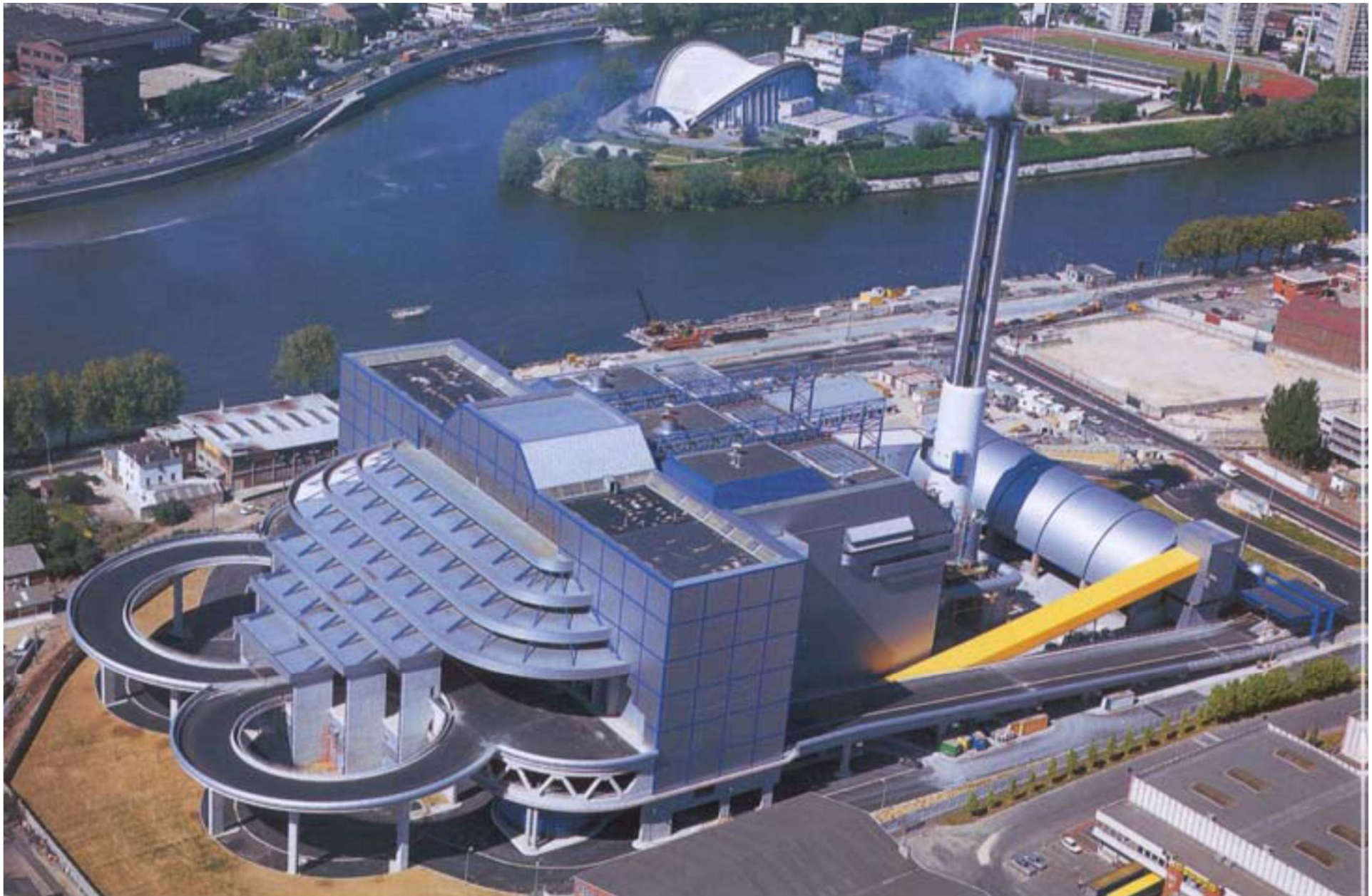
TERMOVALORIZZATORE DI SAINT QUEN(F)
