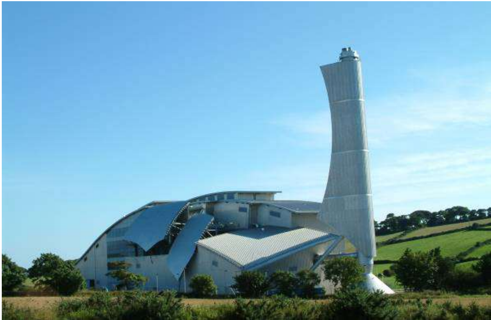
TERMOVALORIZZATORE ISOLA DI MAN GRAN BRETAGNA
