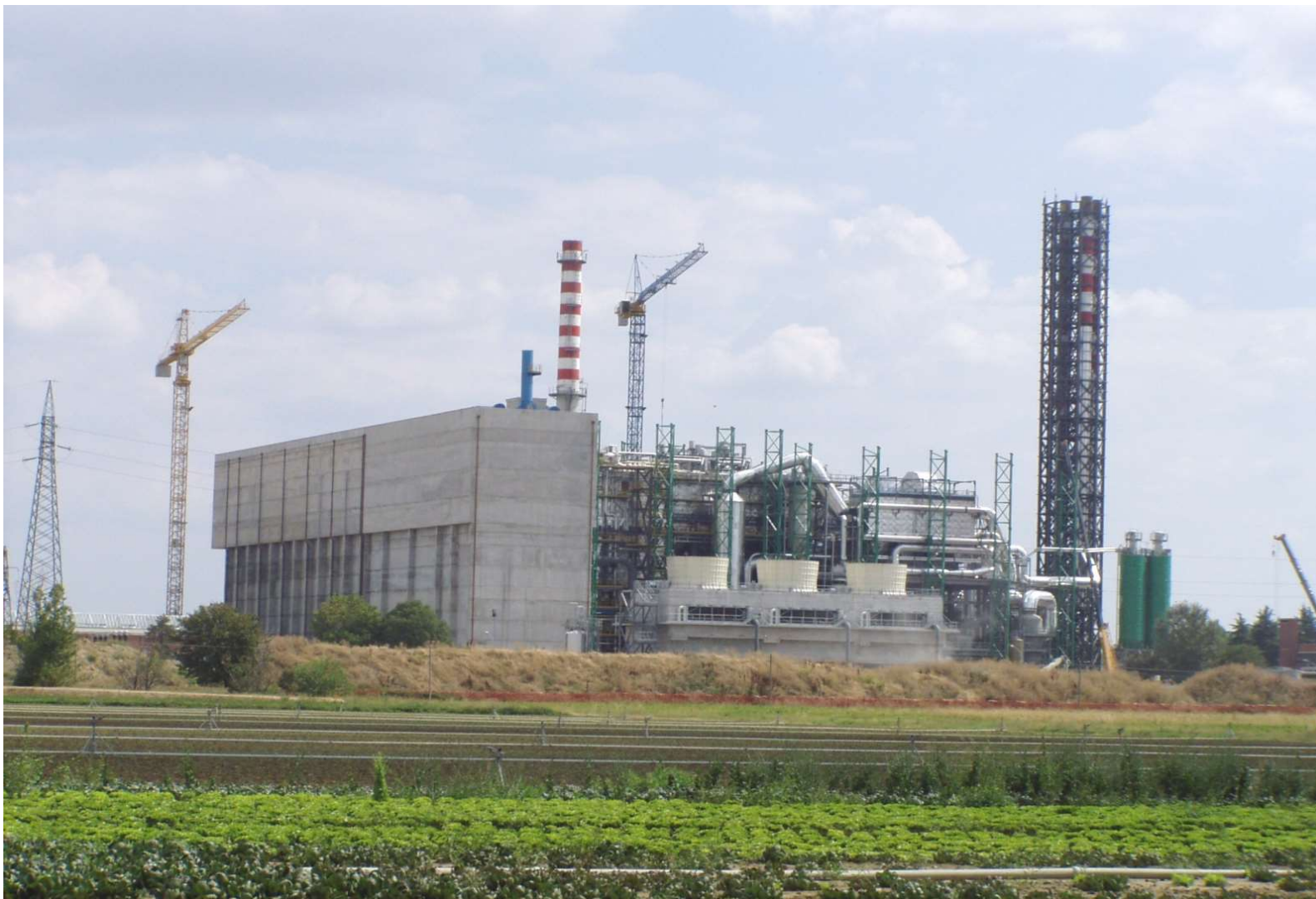
TERMOVALORIZZATORE DI BOLOGNA
